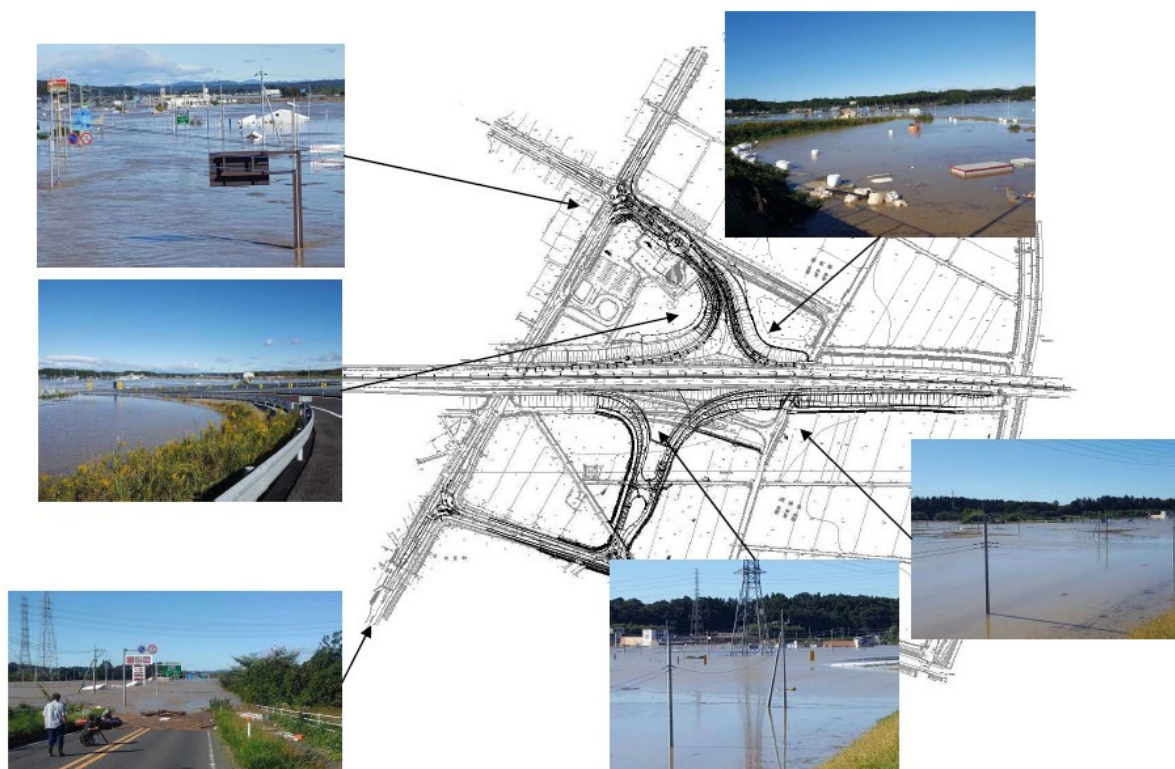
図 2-14 水戸北スマート IC 付近の浸水状況（2019 年 10 月 13 日時点） （提供：NEXCO 東日本）
