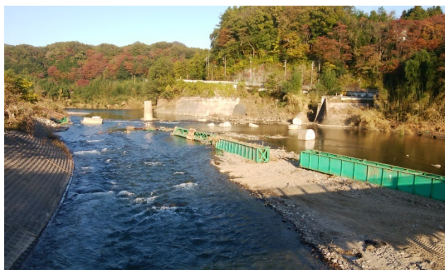
図 2-3 川の中に落とされた桁 (撮影日：2019 年 11 月 10 日，撮影者：信岡尚道)
