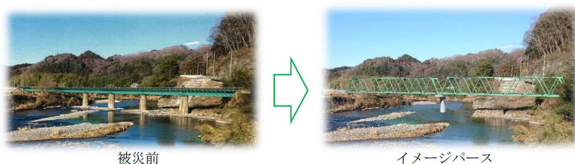
図 2-11 JR 東日本水戸支社が記者発表した水郡線の第六久慈川橋りょうの復旧イメージ (JR 東日本水戸支社のプレスリリースより引用，2020 年 2 月 14 日公表)
