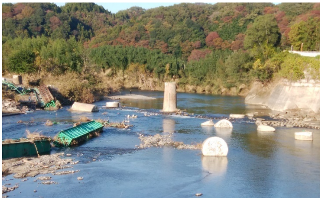
図 2-2 流失した第六久慈川橋りょうと残った橋脚 (撮影日：2019 年 11 月 10 日，撮影者：信岡尚道教)
