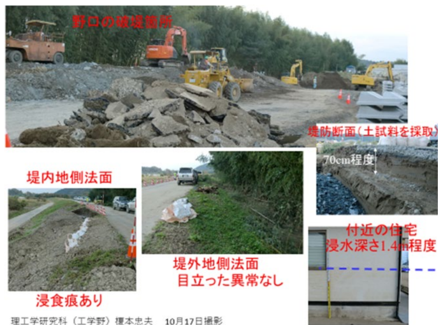
図1 那珂川支流藤井川の堤防決壊（安藤作成資料）
