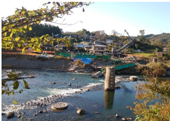
図 2-2 流失した第六久慈川橋りょうと残った橋脚 (撮影日：2019 年 11 月 10 日，撮影者：信岡尚道教)
