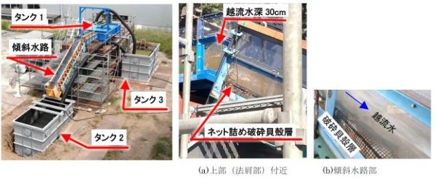
図8 実験規模の越水実験の全景
