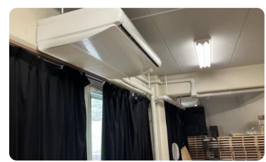
②課外活動施設空調設備更新（水戸キャンパス）
