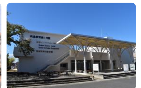
水戸地区講義棟改修 (2023年度竣工)
