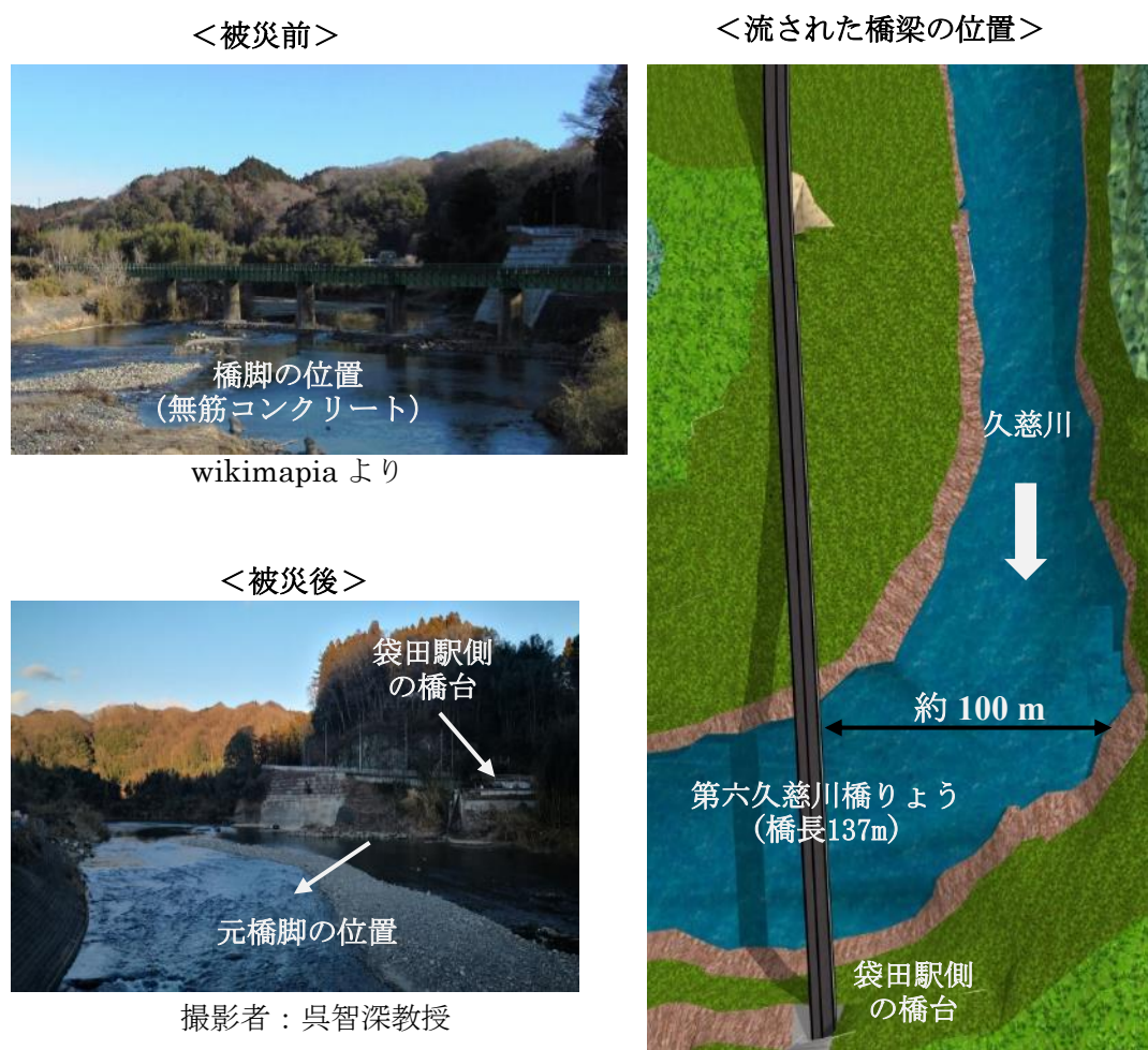
図 2-5 流水方向の特徴 (撮影日：2020 年 2 月 9 日，撮影者：呉智深)
