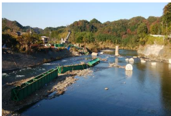
図 2-3 川の中に落とされた桁 (撮影日：2019 年 11 月 10 日，撮影者：信岡尚道)
