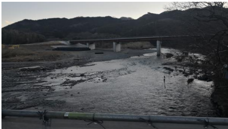
図 2-8 被災後隣の道路橋の状況 (撮影日：2020 年 2 月 9 日，撮影者：呉智深)
