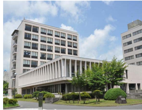
E4 棟（手前）、E5 棟
