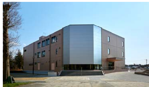
フードイノベーション棟
