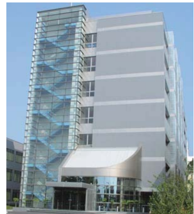
総合研究棟（水戸地区） Integrated Research Building (Mito Campus)
