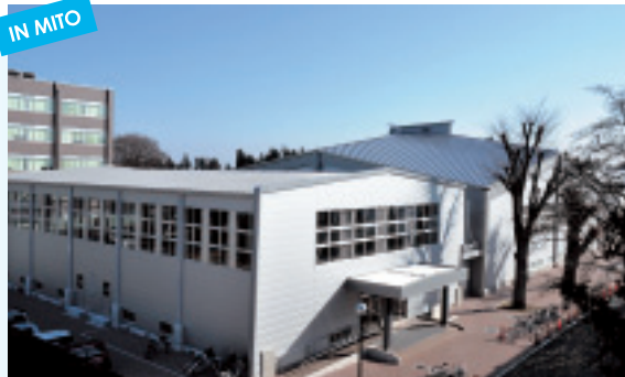
水戸地区体育館外観(南側)
