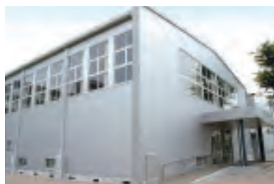
体育館（水戸キャンパス） Gymnasium (Mito Campus)
