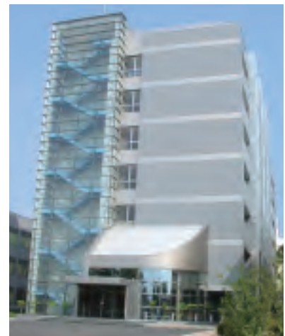
総合研究棟（水戸地区） Integrated Research Building (Mito Campus)
