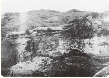
五浦の断崖上に建てら れた日本美術院研究所
