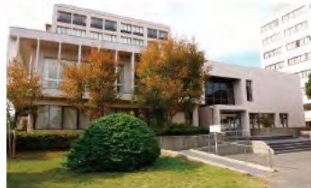
工学部分館（日立キャンパス）
